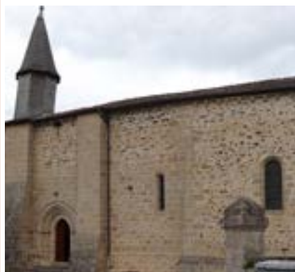
Mur sud de l'église
